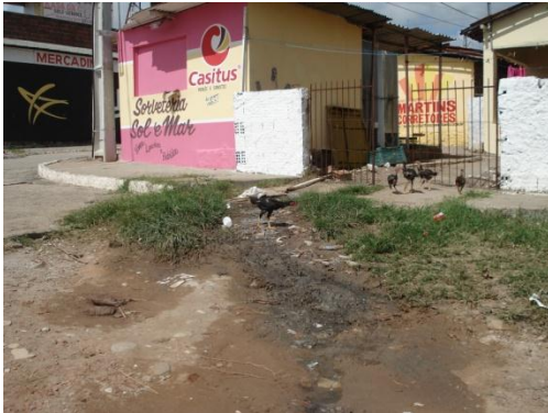
Foto1: Esgoto correndo a céu aberto – de Jacumã.
