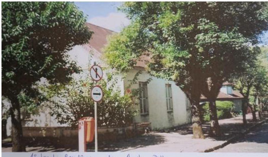
Figura 1 – Primeiro prédio do grupo escolar.
