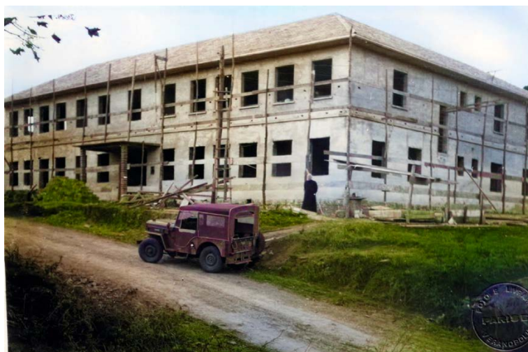
Pároco, padre Pedro Píccoli , em visita às obras de construção do Colégio Santo Antônio de Pádua em setembro de 1961. Em primeiro plano, está o Jipe da paróquia. (Foto: Reprodução Parise. Acervo da Prefeitura de Fagundes Varela).
