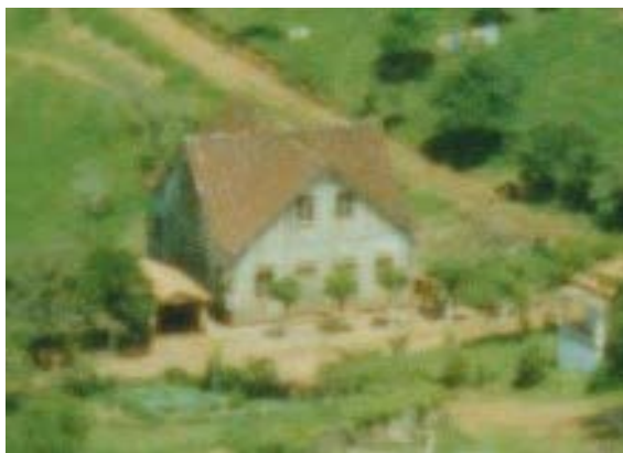
Prédio , em madeira, que abrigou o Grupo escolar, localizado na rua Visconde de Pelotas. (Foto: Acervo de Elígio Parise, 1981).
