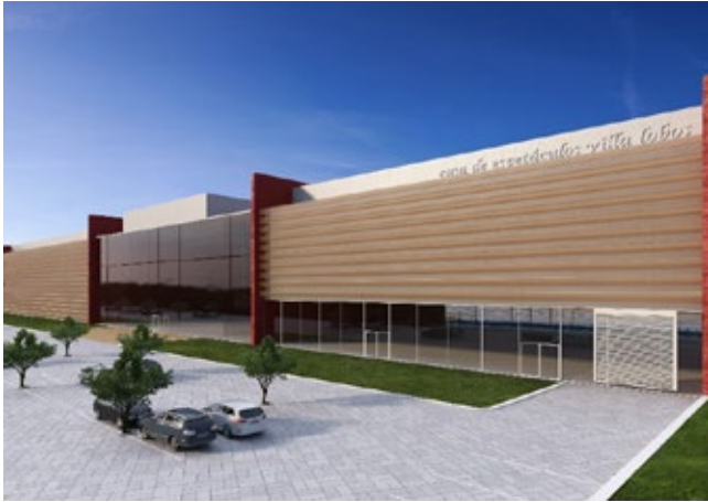
Figura 2 – Fachada da edificação da Casa de Espetáculos
