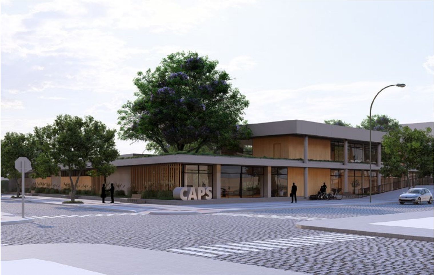
Figura 1 – Visual da esquina principal do Caps III
