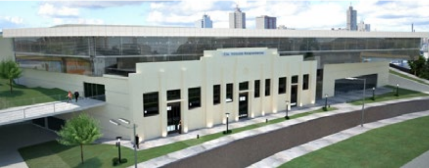
Figura 4 – Vista da edificação
