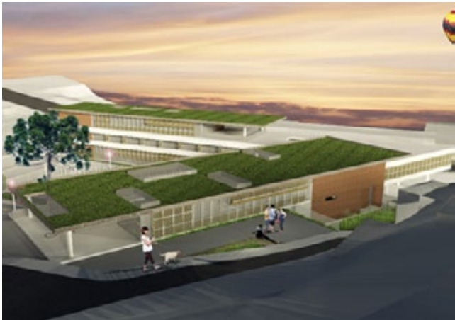
Figura 6 – Visual externa do conjunto
