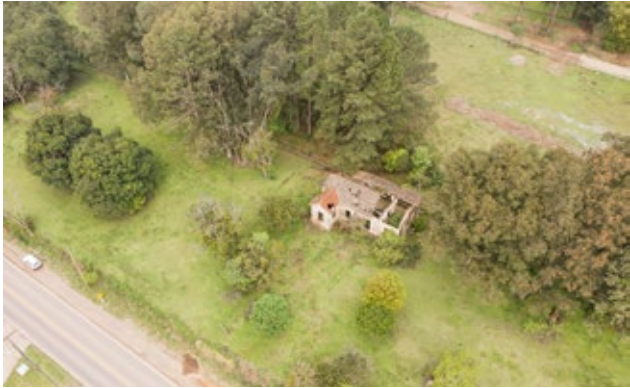
Figura 9 – Situação atual da estação férrea
