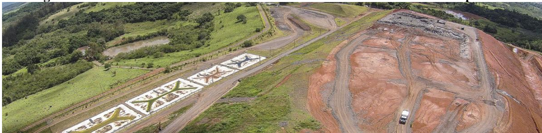
Figura 1 – Central de Tratamento de Resíduos da CRVR – Unidade São Leopoldo
