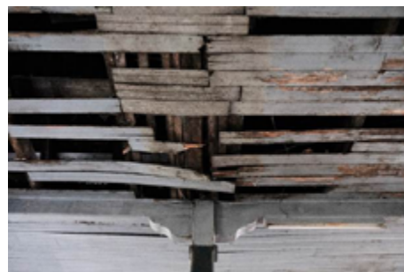
Figura 13: Quebra do forro de madeira
