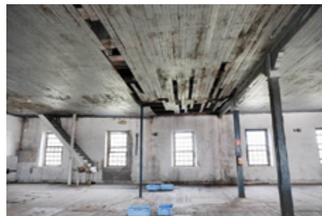
Figura 12: Estado de conservação atual do forro de madeira – módulo 2
