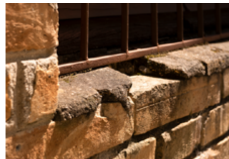
Figura 11: Pingadeira da esquadria inferior com partes faltantes da residência nº 2
