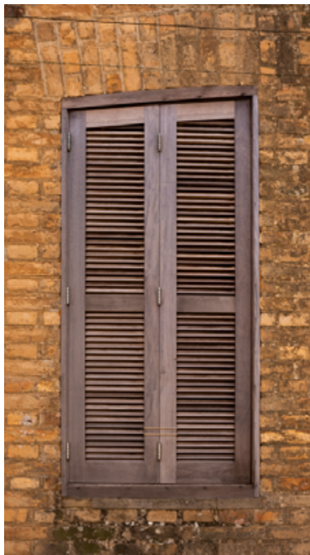
Figura 14: Fotografia de edificação nº 5, que apresenta esquadrias, peitoris e pingadeiras de mesma configuração que a edificação nº 8.
