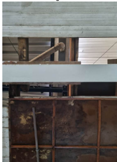
Figura 12: Calha instalada diretamente sobre o forro original.
