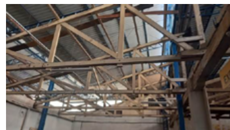
Figura 9: Ruína de treliças de pinho e vigamentos em madeira.
