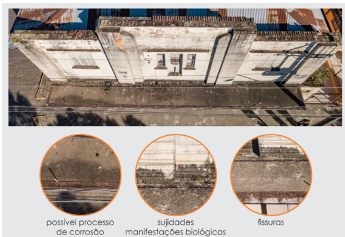
Figura 20: Face superior da marquise e detalhes de manifestações identificadas.
