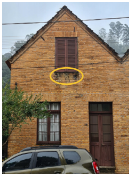
Figura 10: Foto com marcação de manifestação patológica ocorrendo abaixo da esquadria superior da residência de nº 2.
