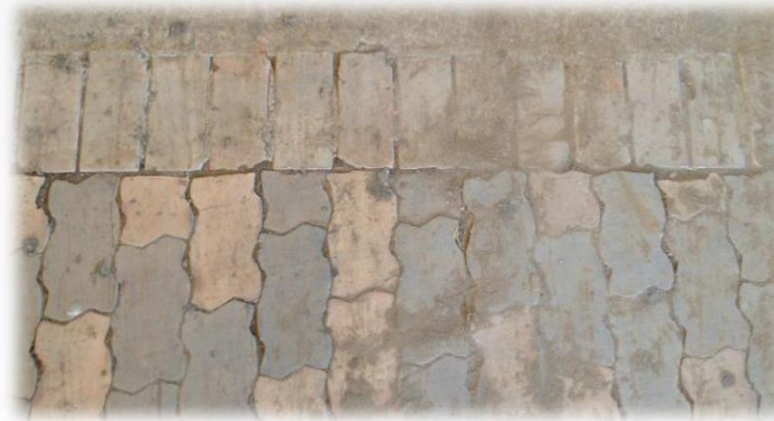
Adoquim sendo utilizado como pavimento flexível na Cerâmica Arte Sardinha, em Campos dos Goytacazes-RJ.
