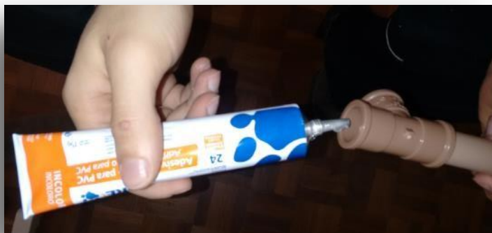
Figura 04: Utilização da cola. A cola deve ser passada na parte interna das conexões e após na ponta do cano que entrará na mesma.
