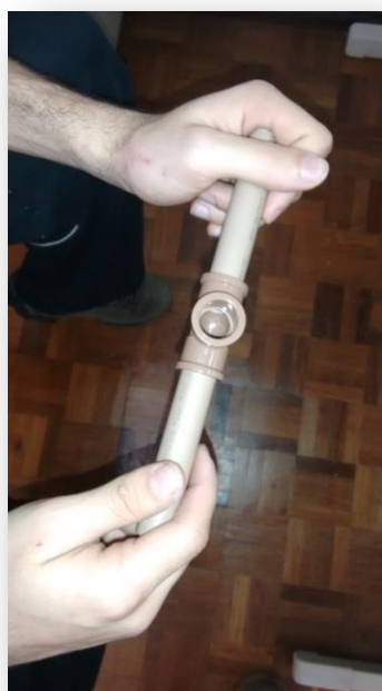
Figura 05 e 06: Certificar que o cano entrou aproximadamente até a marcação.
