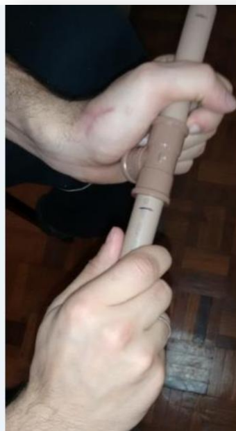
Figura 05 e 06: Certificar que o cano entrou aproximadamente até a marcação.
