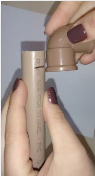
Figura 03: Marcação das conexões. Para facilitar a colocação das conexões nos canos, determine a profundidade da conexão e marcar esta profundidade na ponta de todos os canos. Marcação para todas as conexões.
