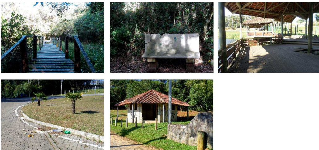
Figura 2: Degradação no JBCS. 2014
