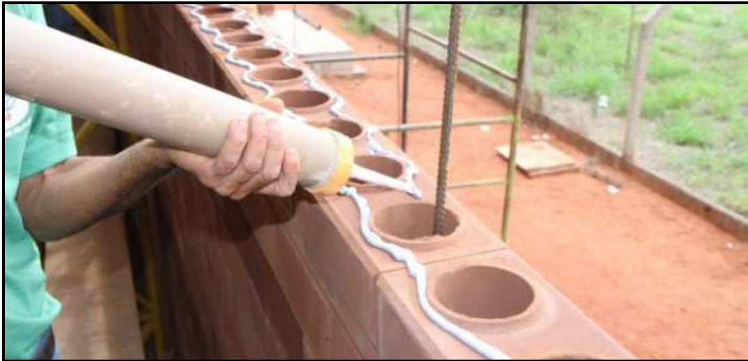
Figura 2 – Assentamento de tijolo ecológico com argamassa polimérica
