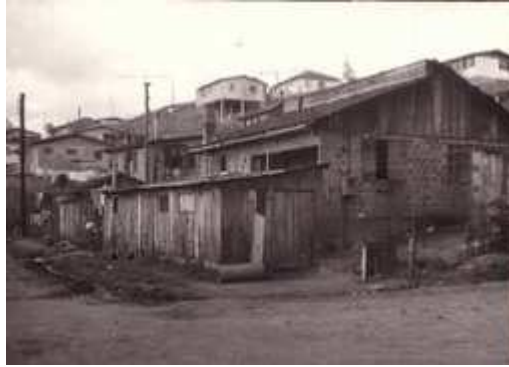
Figura 29 - Loteamento clandestino São Caetano (Olaria). Levantamento de sub-habitações – 1984.
