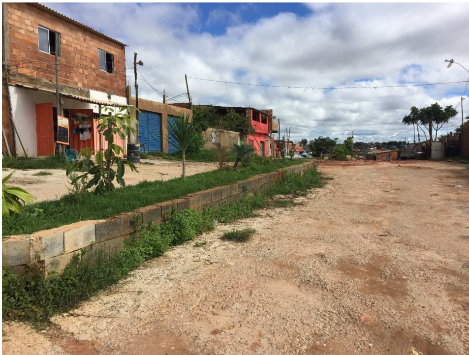
Figura 10 – Canteiro na avenida principal da ocupação Dandara, 2016
