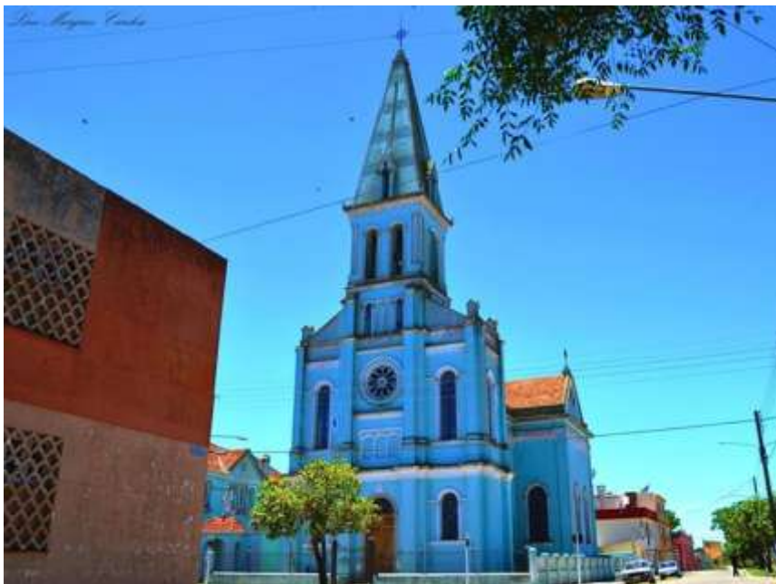
Figura 2 – Fachada da Igreja Matriz Imaculada Conceição, no centro histórico de Jaguarão.
