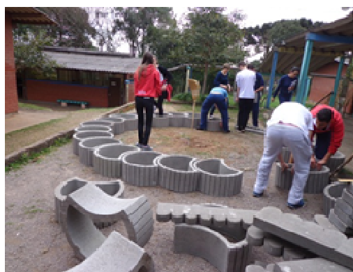
Figura 2 – Medição do local e colocação das estruturas
