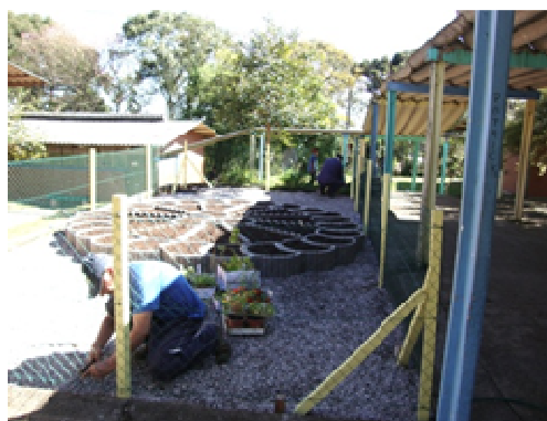
Figura 4 – Colocação da cerca de proteção por funcionários da UCS-Carvi supervisionados pelo Sr. Dorval Brandelli
