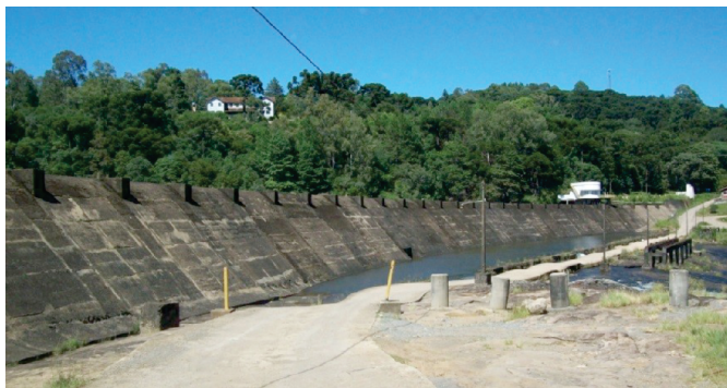
Barragem do Salto
