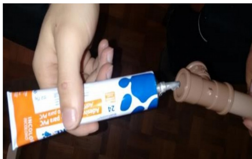
Figura 4 - A cola deve ser passada na parte interna das conexões e, após, na ponta do cano que entrará nela.
