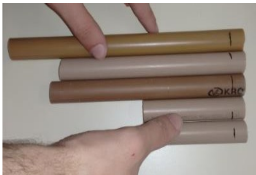
Figura 3 - Marcação das conexões. Para facilitar a colocação das conexões nos canos, determine a profundidade da conexão e marcar esta profundidade na ponta de todos os canos. Marcação para todas as conexões.
